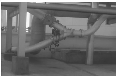
图2 管道分流器现场水平安装方式图
