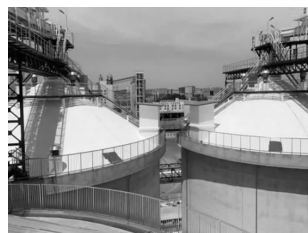
图7 陶瓷微粒水性热反射涂料实仓应用展示图
